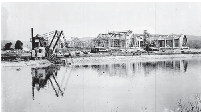
TAK SE STAVĚLO „ÁČKO“. Foto: archiv BV
